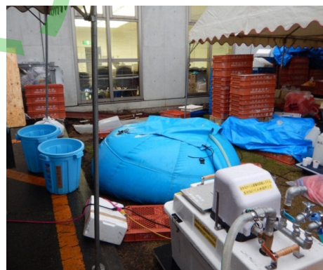
【写真 6】益城町総合体育館避難所の仮設受水容器（2016）
