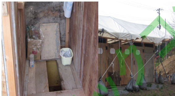
写真2 広田小学校避難所の素掘式トイレ
