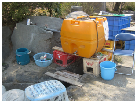
【写真 11】 避難所の簡易受水槽（2011 岩手）
