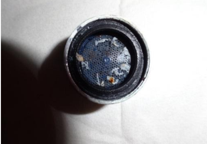
取り外した整流器内部の網目
