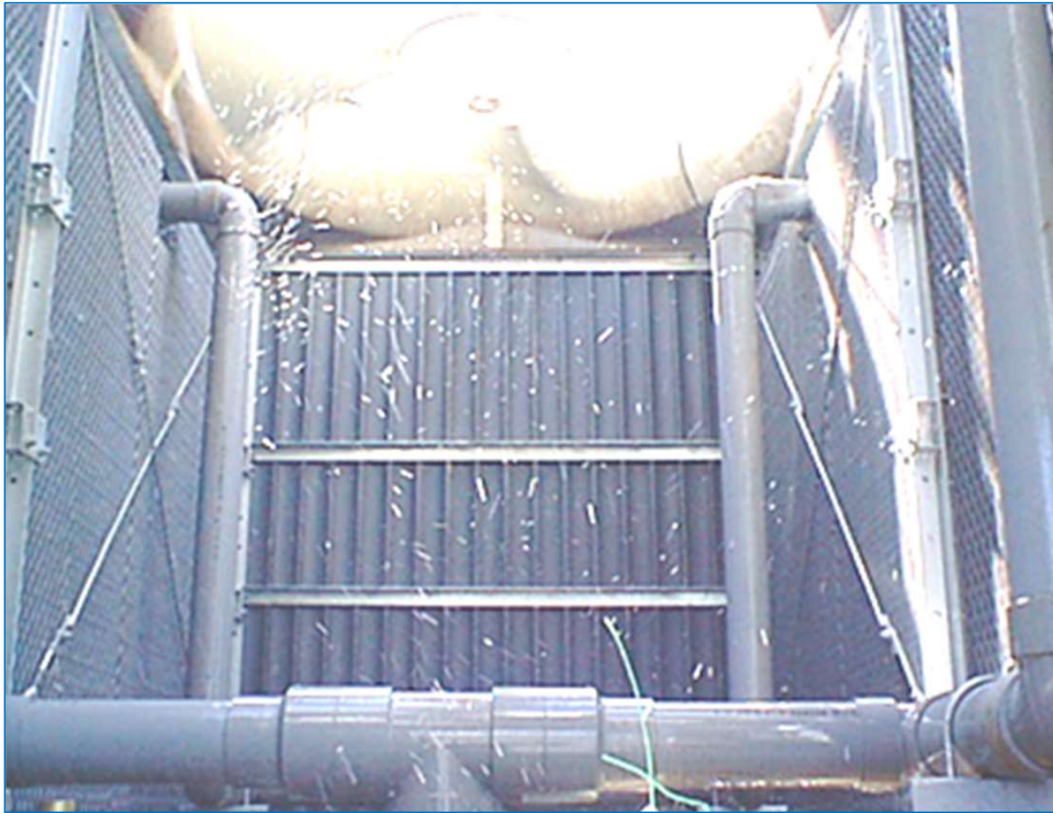
冷却塔内部の 飛散水の様子
